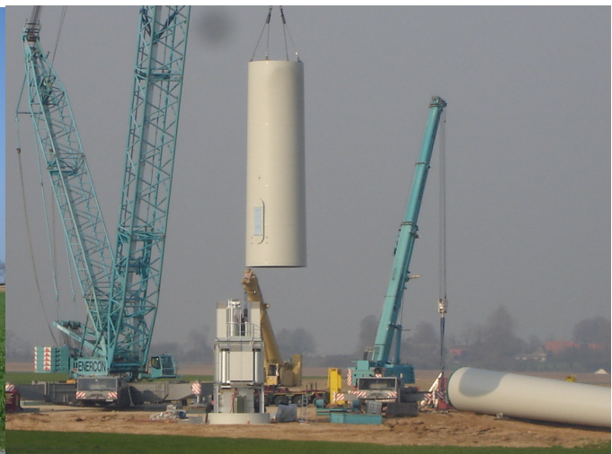
Pose du 1 er élément de mât
